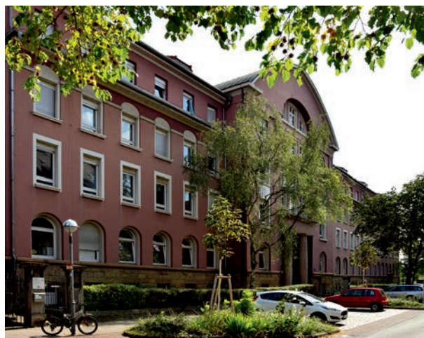
Das Sybelcentrum, errichtet 1913, in der Sybelstraße 11 in der Karlsruher Südstadt
